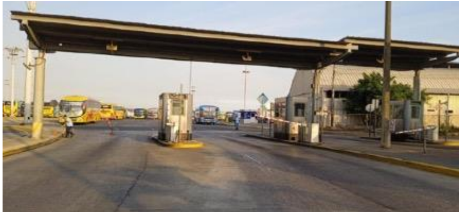
Ilustración Nro. 5 Equipos para repotenciación de parqueo
